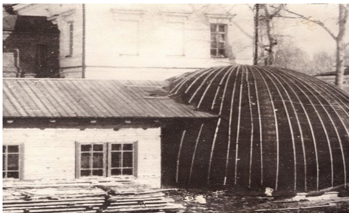
1933г. — в отделении колебаний СФТИ была организована акустическая лаборатория. Во дворе СФТИ был построен макет главного зала ново-сибирского театра в масштабе 1:6, на котором проверялись акустические расчеты
