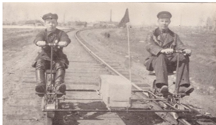
1940г. — испытания ручного привода путевого дефектоскопа проводят Иванчиков В.И. и Сапожников А.Б.
